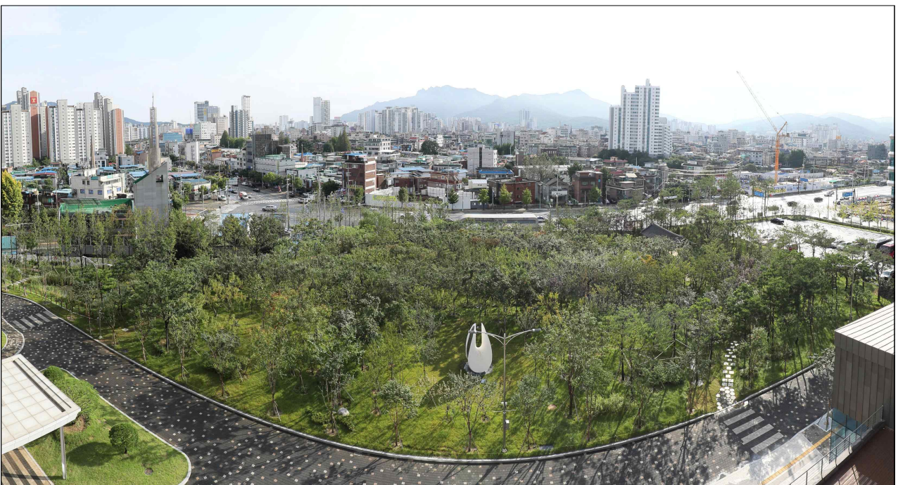
평화의 숲 조성 (후)
